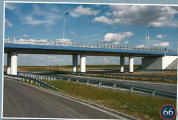
66 Obwodnica Nowych Skalmierzyc Nowe Skalmierzyce Ring Road
