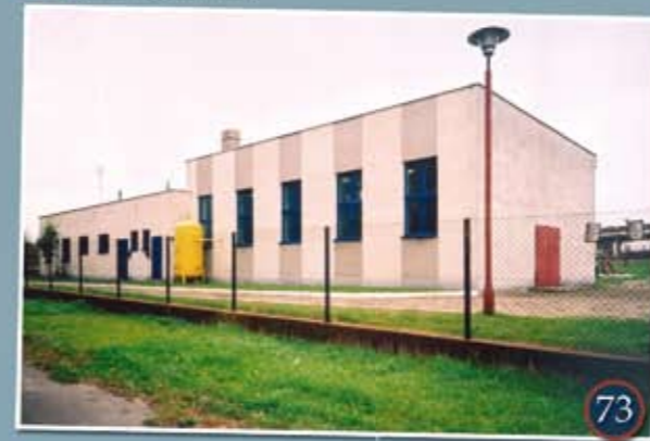
73 Stacja uzdatniania wody Conditioned water station
