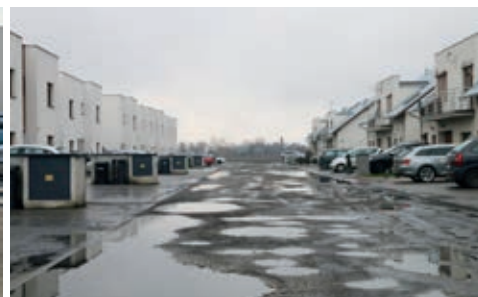
Ulica Krótka przed przebudową
