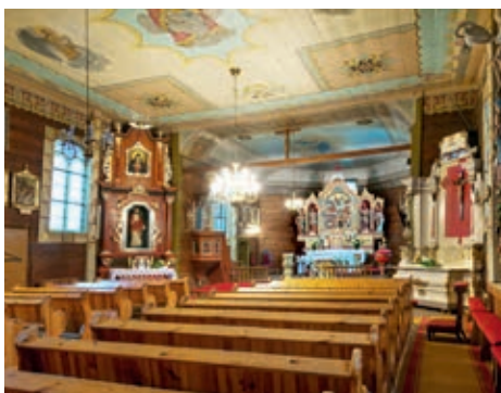
Dzięki dotacji w kościele w Droszewie zostanie wyremontowany m.in. strop
