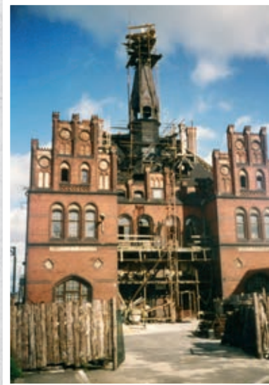
Remont dworca - rok 1995
